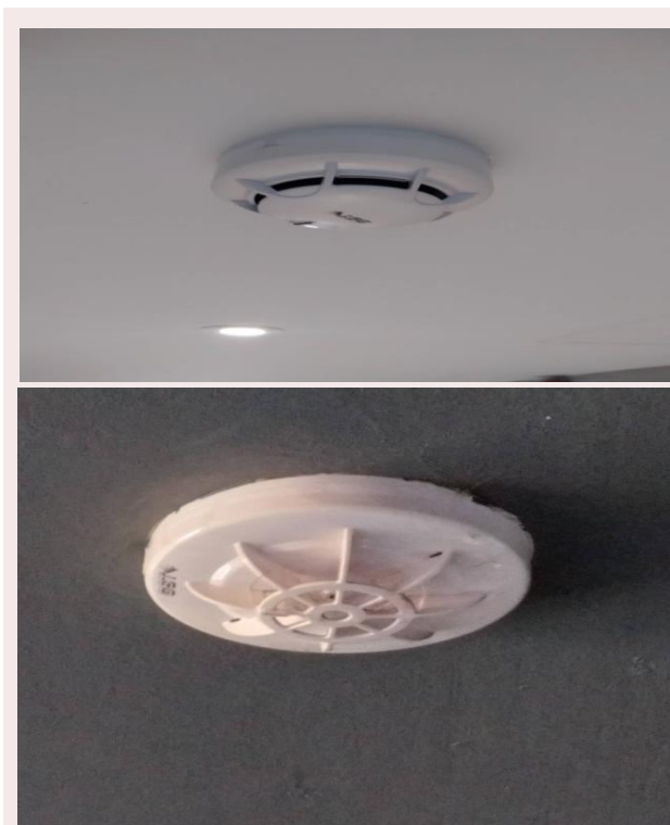
ภาคผนวกที่ 3.43 Smoke&Heat detector
